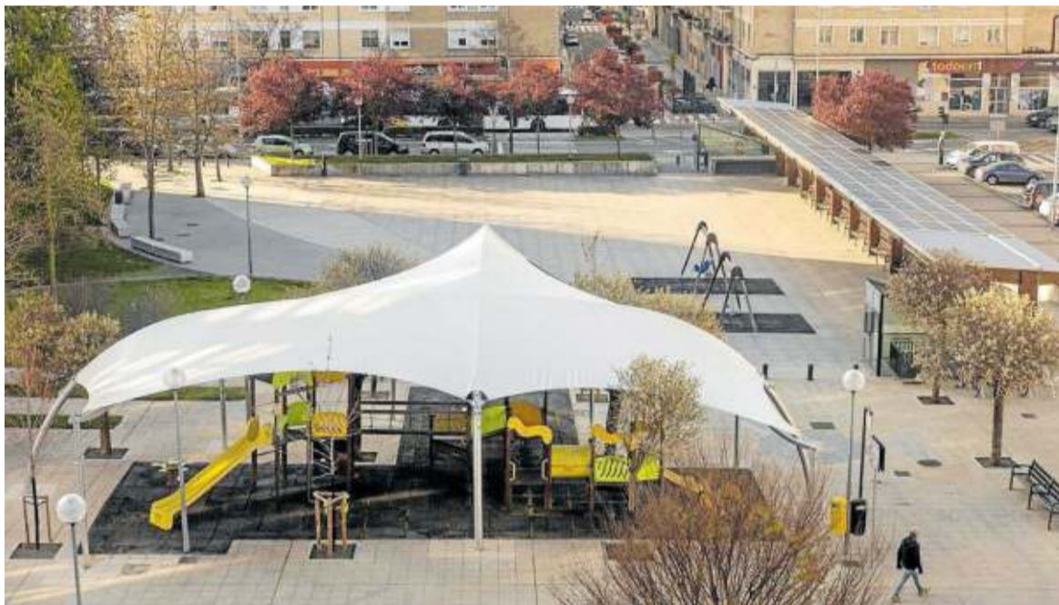
La zona infantil y a la derecha, la nueva instalación fotovoltaica. Foto: Iban Aguinaga
